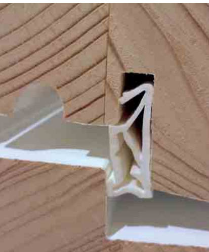
Detail těsnění dřevěného eurookna
