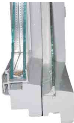
Detail výměny vnějšího zasklení za PVC profil s dvojsklem
